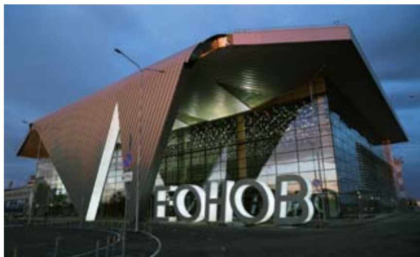
Строительство нового терминала международного аэропорта Кемерово обошлось в итоге в 5 млрд рублей
