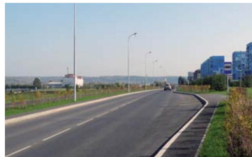
На новый участок проспекта Московского, соединивший проспект Ленинградский и бульвар Строителей было направлено почти 91 млн рублей
