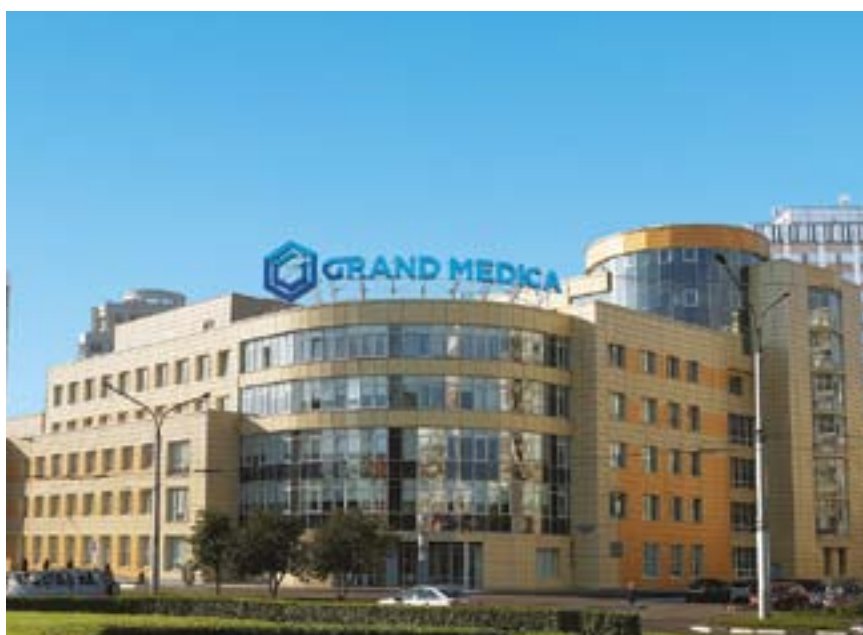
Инвестиции АО «Инрусинвест» в строительство центра составили 3,7 млрд рублей. По итогам прошлого года ООО «Гранд Медика» стало крупнейшим по выручке, 488 млн рублей, медицинским предприятием Кемеровской области
